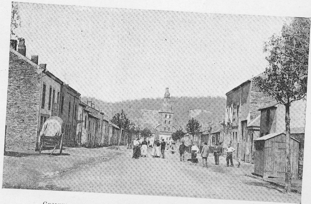
GESPUNSART. — Rue de Pussemange. (Vue prise de l'École de Garçons.)
